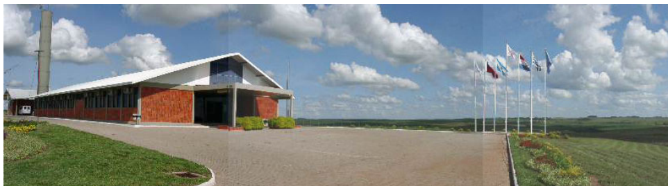
Figura 20 - Vista do Prédio 2 do OES/CRSSPE/INPE – MCT em São Martinho da Serra – RS (Fonte: http://www.crspe.net/ )
